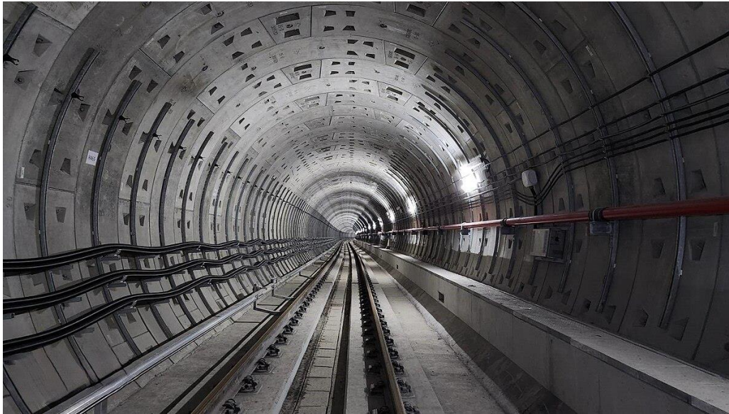
Рис. 1.5. Перегінний тунель метрополітену ( https://surl.lt/vrvxtn )
