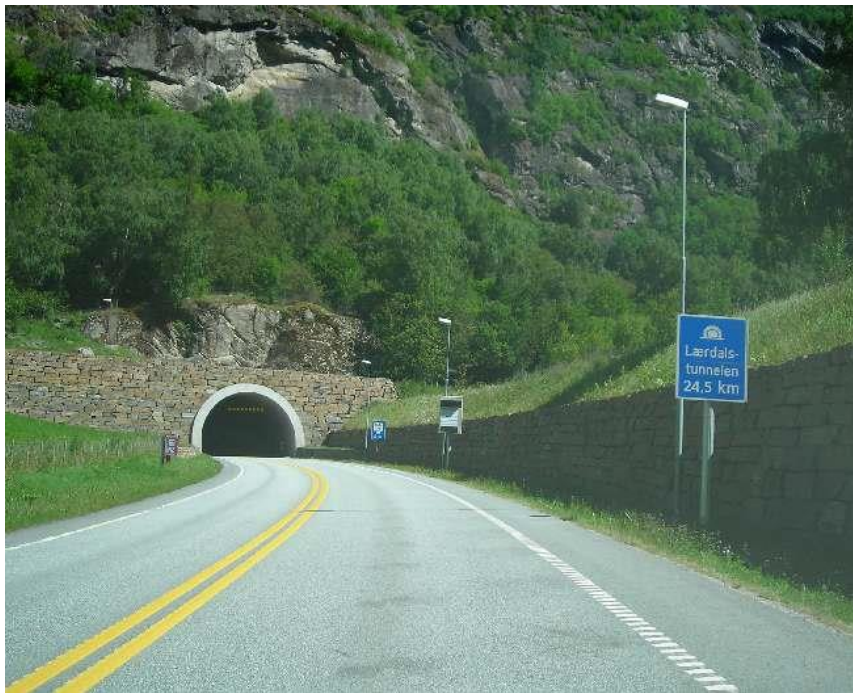
Рис. 1.3. Автодорожній тунель ( https://surl.li/dxqaga )
