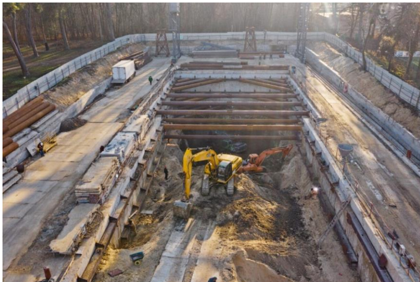
Рис. 1.10. Відкритий спосіб робіт при спорудженні тунелів у котловані ( https://surl.li/vqummp )
