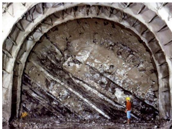
Рис. 2.14. Вид забою при проходці гірських масивів ( https://surl.li/ltjhcp )
