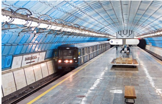
Рис. 1.7. Станційний тунель метрополітену односклепінчастої станції ( https://surl.lt/ohfxfp )
