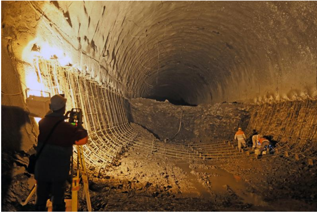
Рис. 1.13. Спосіб нижнього уступу, розширення перерізу тунелю до проектного контуру ( https://surl.li/rbifjd )
