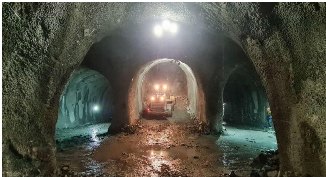
Рис. 1.12. Виробка тримається на тимчасовому кріпленні, гірничий спосіб спорудження тунелів ( https://surl.lt/ejshon )
