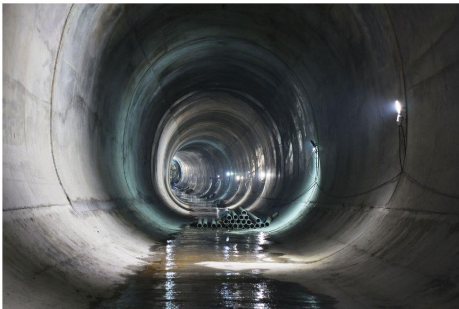
Рис. 4.22. Оправа перегінного тунелю метрополітену ( https://surl.li/ovsxzd )
