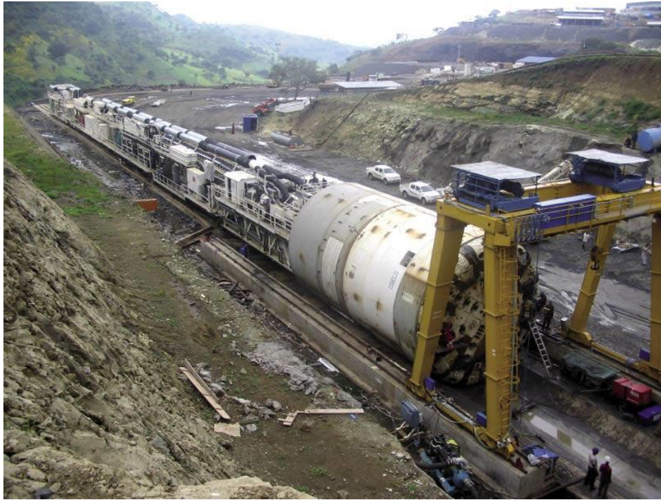
Рис. 1.14. Щит і щитовий комплекс, зібраний на будівельному майданчику ( https://surl.li/yevfcw )
