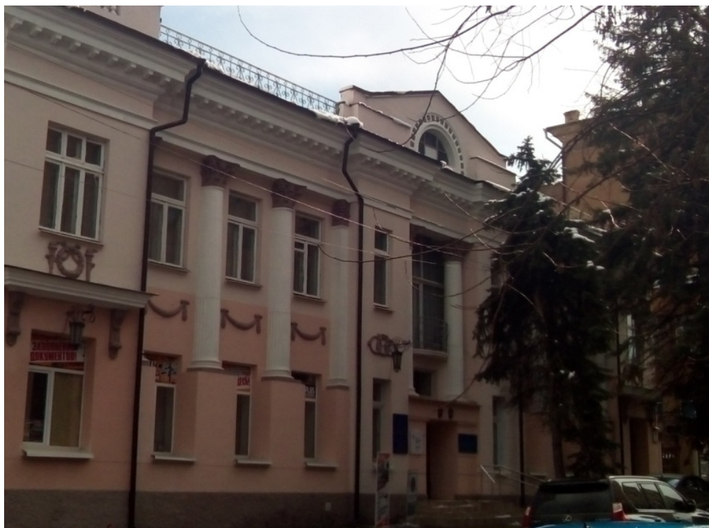
731. Будинок вчених (вул. С. Єфремова)
