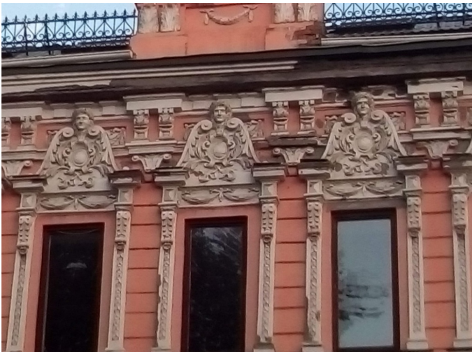
796. Добре відреставрована ліпнина на фасаді будівлі Арона Тавровського (вул. Січових Стрільців)
