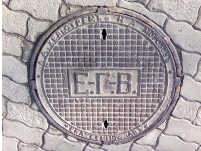
144. Написи на люку: «А. А. Хельстремъ и Н. А. Морозовъ», «Екатеринославъ», «Е.-Г.-В.» (Екатеринославский городской водопровод)
