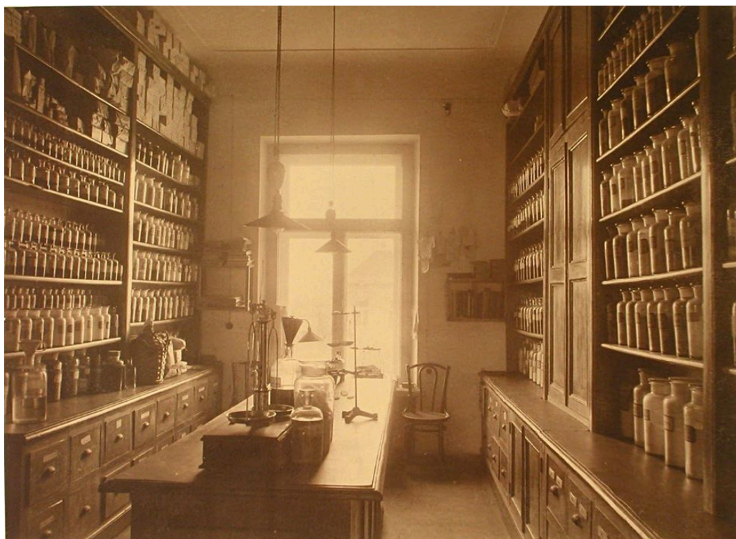
611 Приміщення аптечного складу лікарні Червоного хреста
