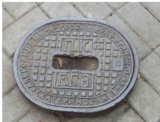
138. Написи на люку: «Александровській Южно-Російській заводъ Брянскаго об-ва», «Екатеринославъ», «Е.-Г.-В.» (Екатеринославский городской водопровод).
