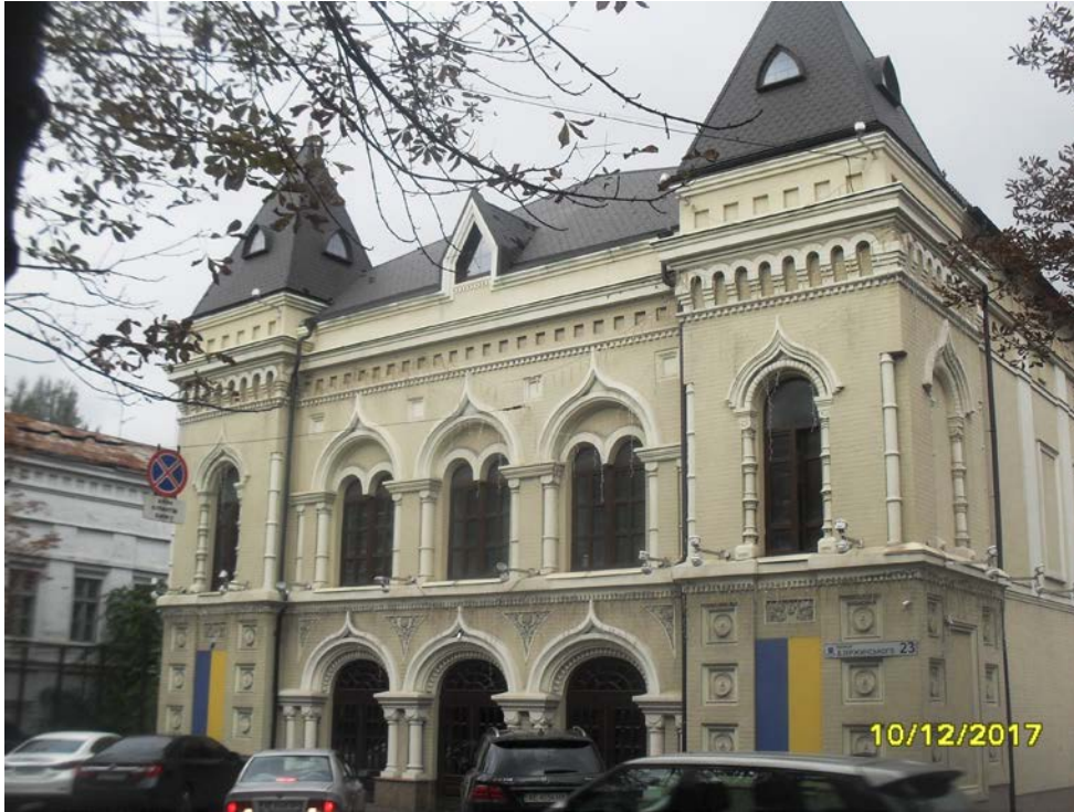
683. Будівля комерційного клубу в наш час (вул. В. Вернадського, 23)
