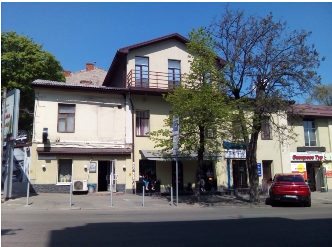
794. Будинок з дерев'яним мезоніном (вул. Січових Стрільців)
