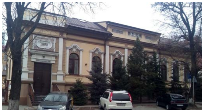
636. Будівля 1890 р. будівництва (площа Успенська)
