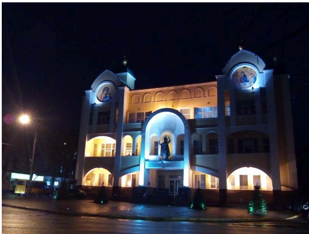
308. Єпархіальний центр УПЦ МП у нічному освітленні
