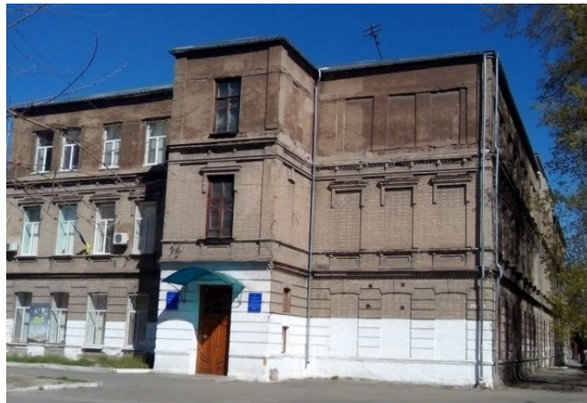
634. Будівля 22 школи (нині – Дніпровський театрально-художній коледж)
