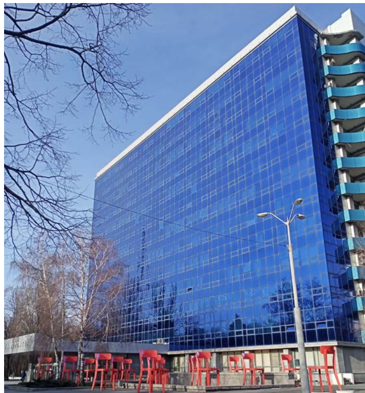
258. Корпус гуманітарного факультету Дніпровського національного університету імені Олесь Гончара
