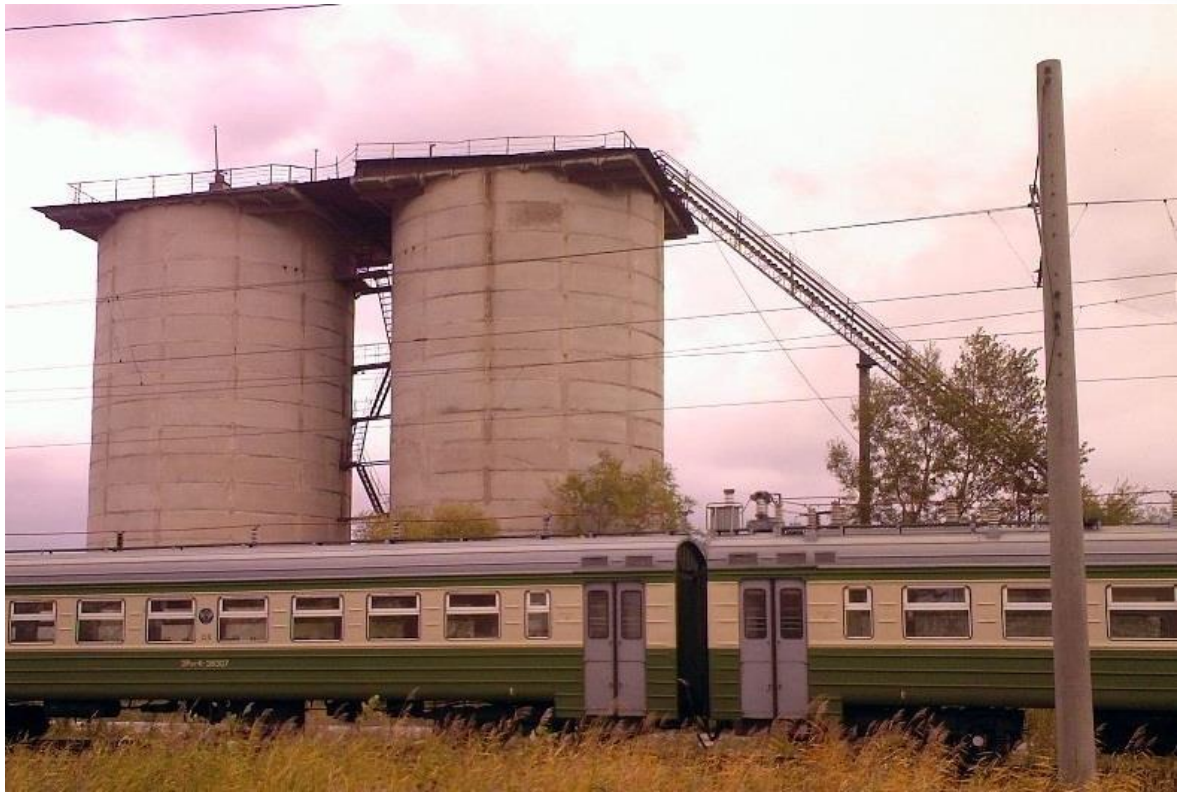
Рисунок 3.12 – Загальний вигляд баштового складу сухого піску.
