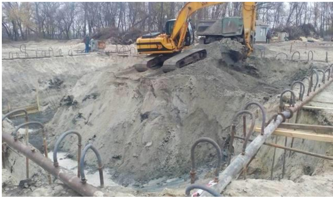
Рис. 8.2. Одноярусне глибоке водозниження котлованів
