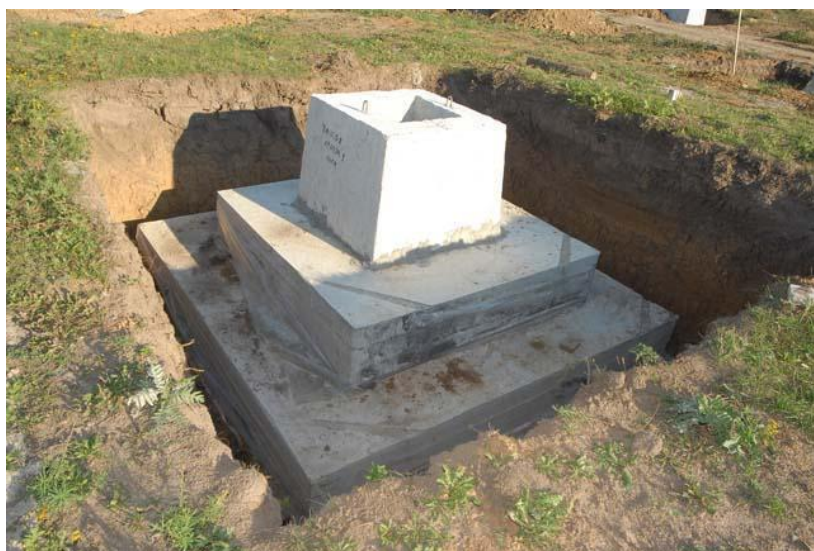
Рис. 3.5. Фундамент на суходолі у котловані.
