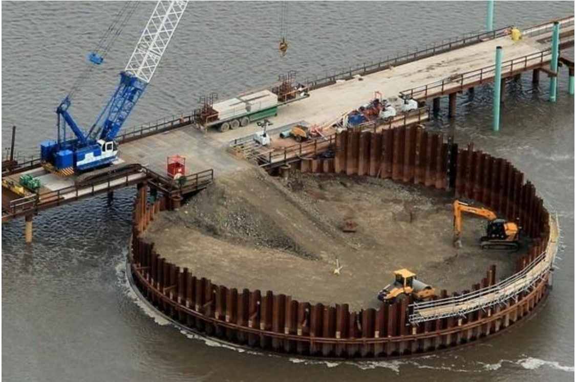
Рис. 15.4. Шпунтове огородження острівця
