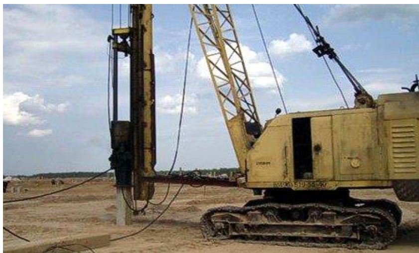
Рис. 13.2. Забивка палі копром
