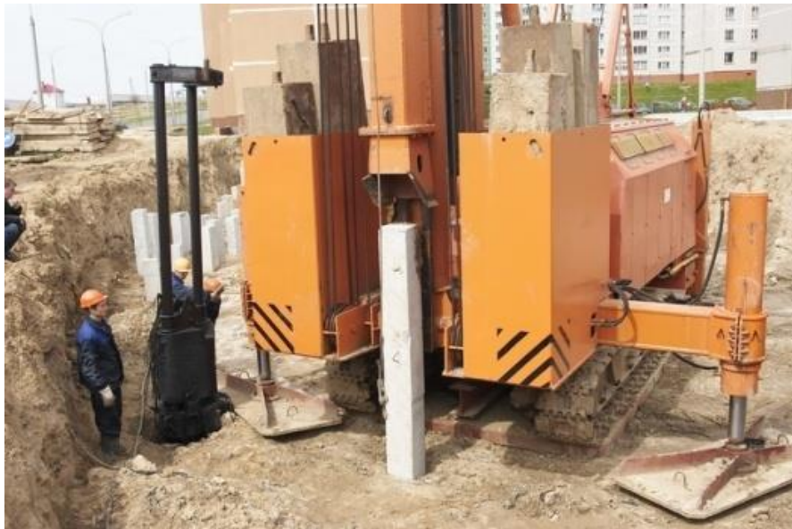
Рис. 13.3. Занурення палі вдавлюванням
