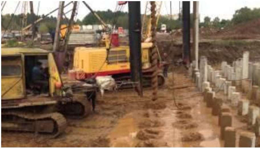
Рис. 13.4. Буріння лідируючої свердловини
