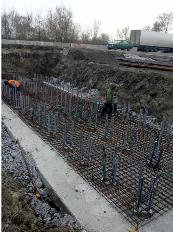
Рис. 14.4. Роботи з армування ростверку пальового фундаменту
