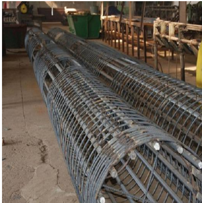
Рис. 13.7. Арматурний каркас буронабивної палі
