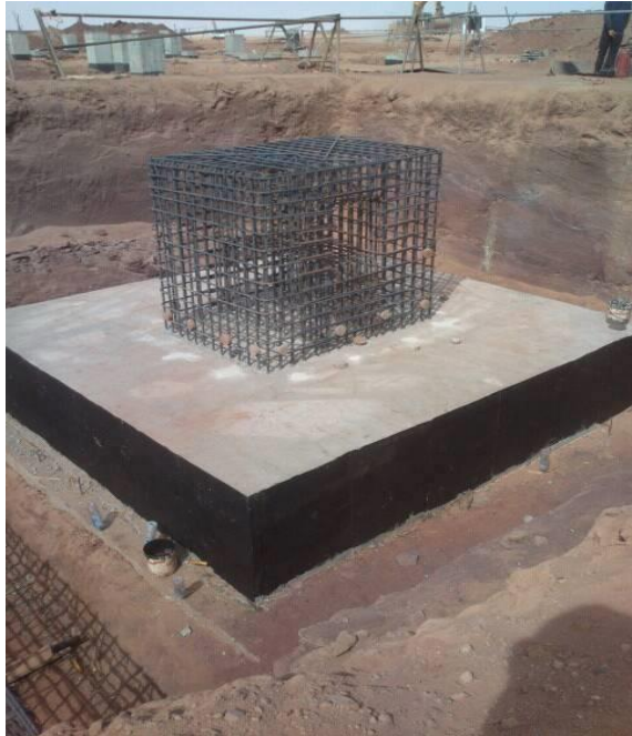
Рис. 6.16. Фото забетонованого фундаменту
