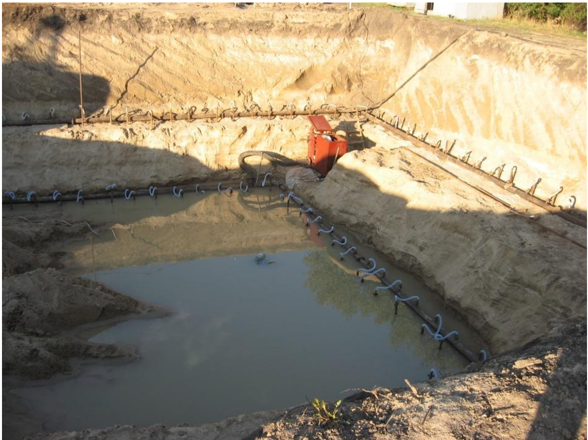
Рис. 8.3. Глибоке водозниження двома ярусами
