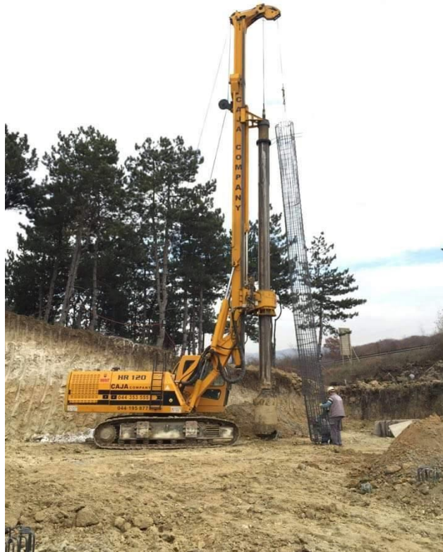
Рис. 14.3. Установа для спорудження буронабивних паль
