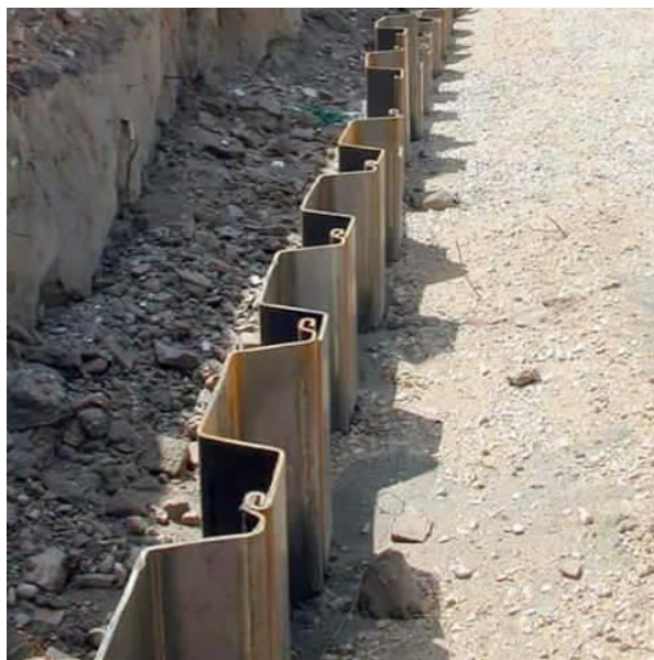
Рис. 7.3. Шпунтове огородження з металевго шпунту
