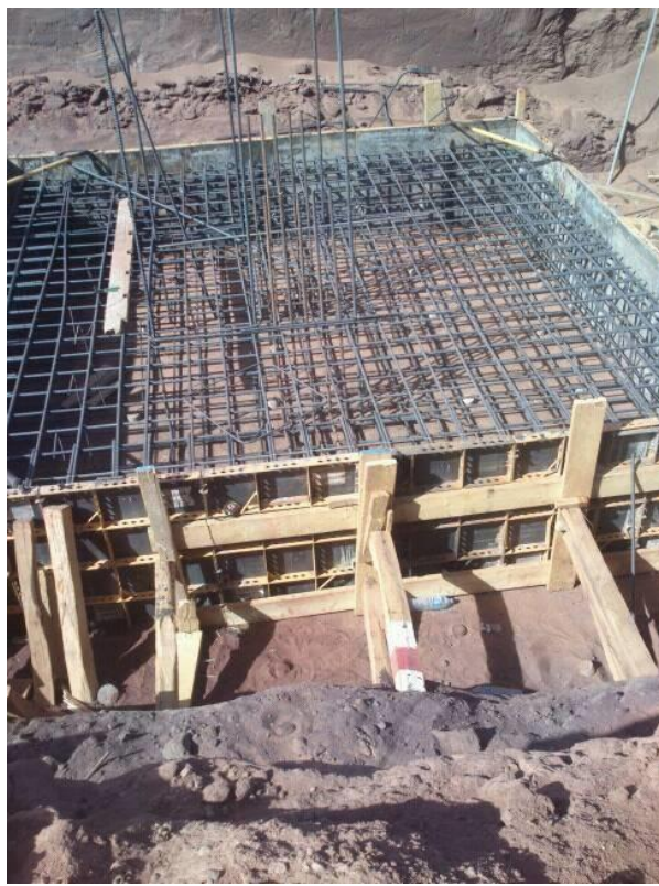
Рис. 6.15. Установка опалубки та укладання арматурного каркасу
