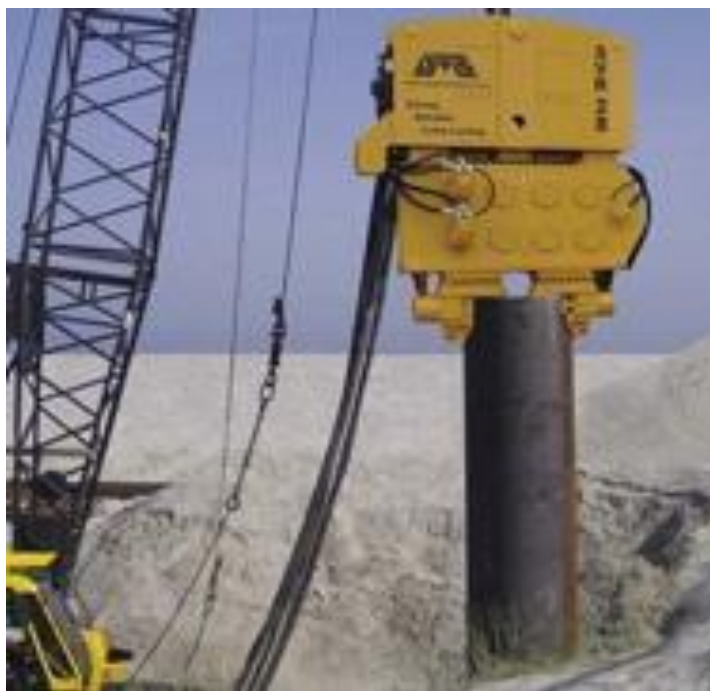
Рис. 13.5. Занурення палей вібромолотом
