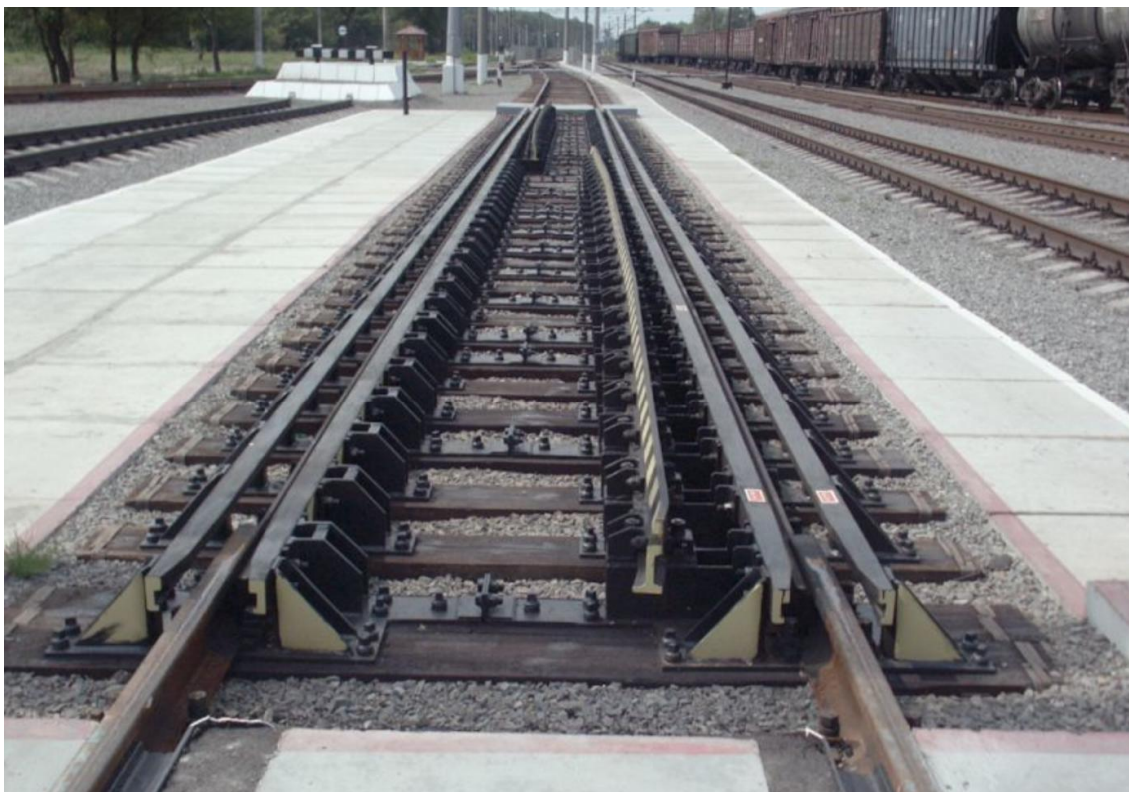
Рис. 2.11. Колієперевідний пристрій SUW 2000
