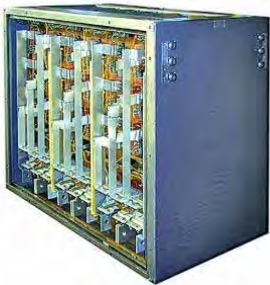
Рис. 16.18. Випрямна установка М-ТПП-3000 У2
