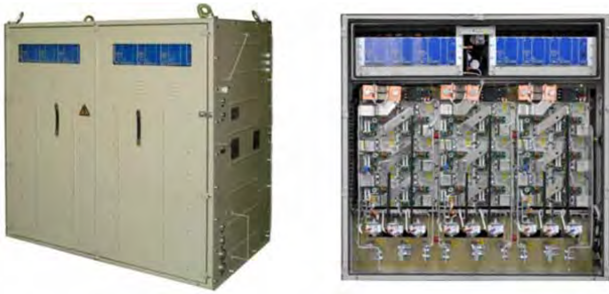
Рис. 16.19. Випрямна установка ВУТГ-6600/800-У2
