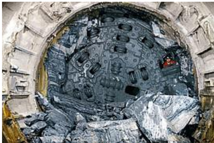
Рис. 16.5. Вид робочого органу щита "Херренкнехт" після проходки тунелю
