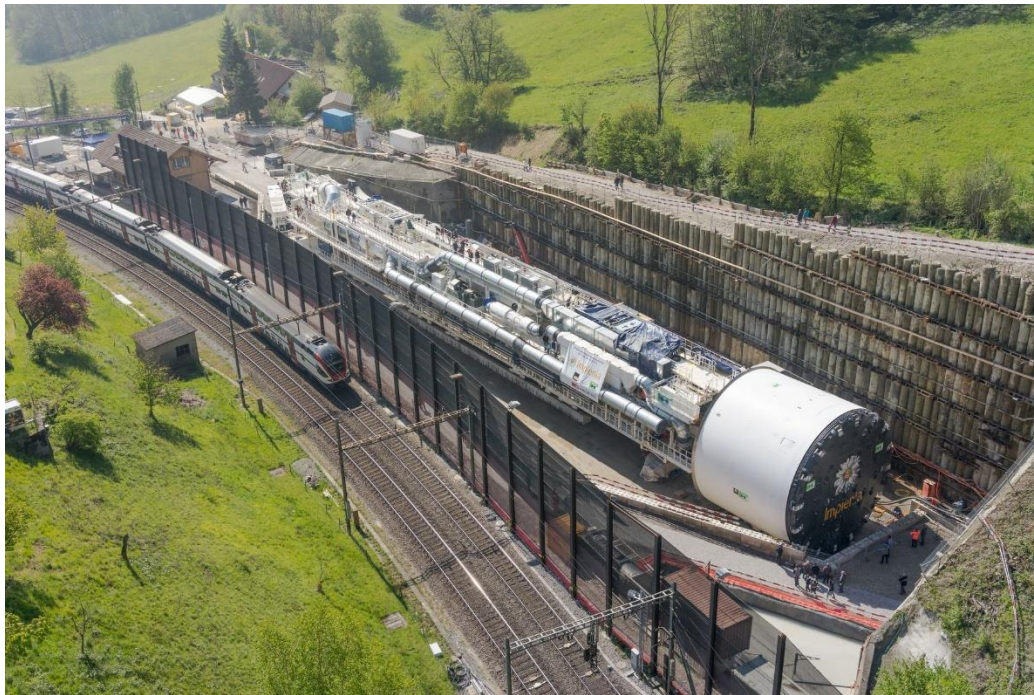
Рис. 14.1. Тунелепрохідницький комплекс на будівельному майданчику у передпортальній виїмці.
