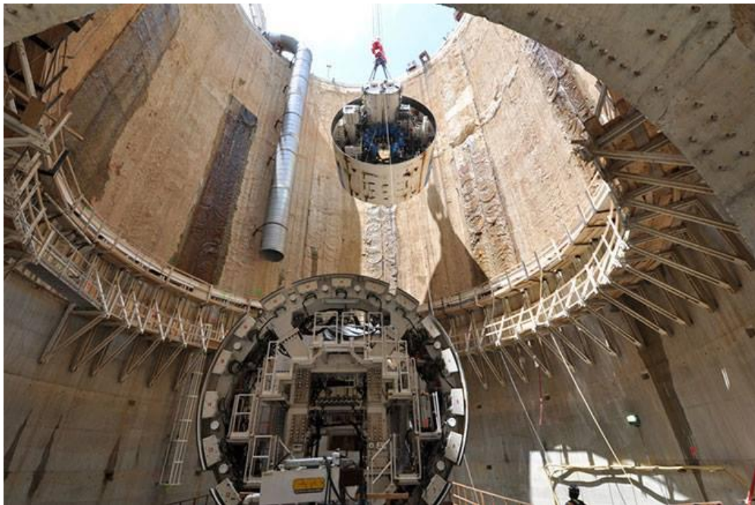
Рис. 14.6. Монтаж щита через шахтний стовбур
