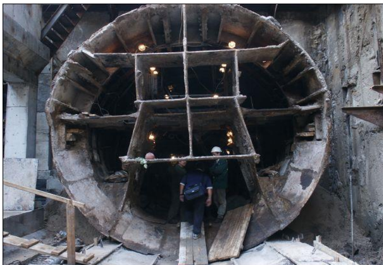
Рис. 1.4. Щитовий спосіб проходки немеханізованим щитом.
