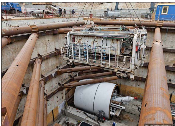
Рис. 1.5. Монтаж тунелепрохідницького комплексу у котловані.
