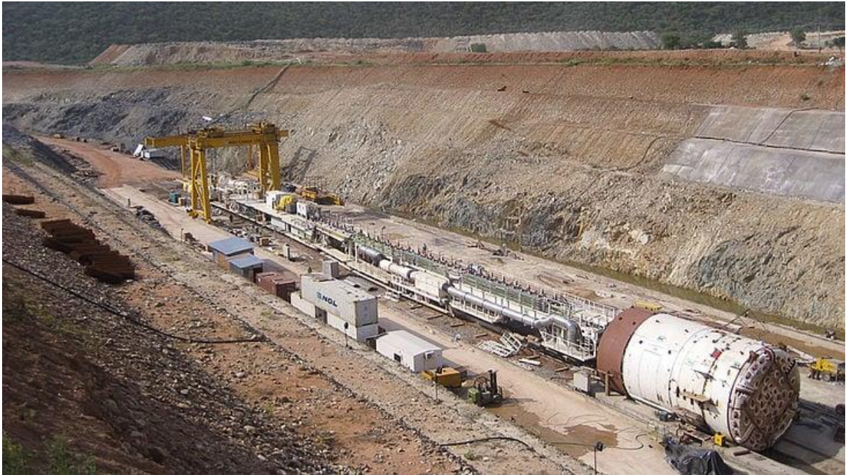
Рис. 14.9. Монтаж щитового комплексу у передпортальній виїмці
