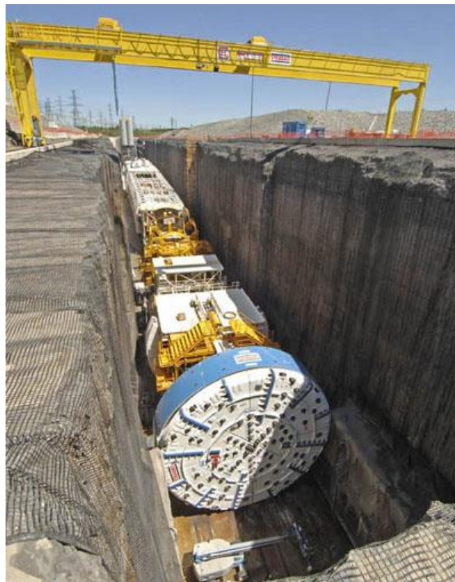
Рис. 1.6. Монтаж тунелепрохідницького комплексу у котловані.
