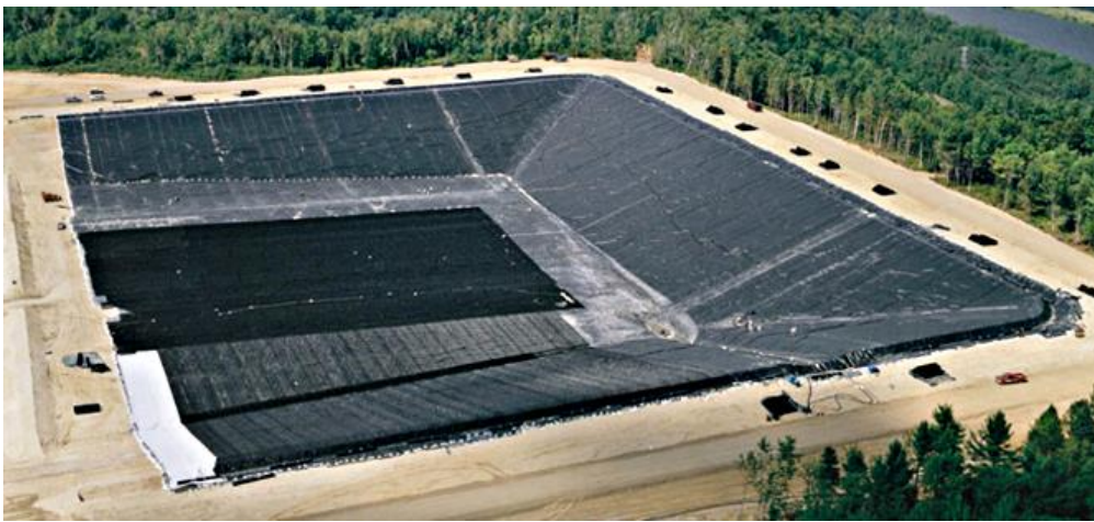
Рисунок 4.1 – Підготовка ділянки сучасного полігону для захоронення відходів з використанням геомембрани HDPE [30]
